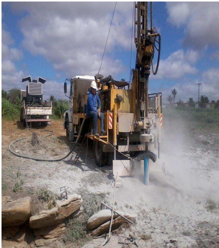
Perfuração de Poço Profundo Realizada em situação de emergência para atender pequenas comunidades.
