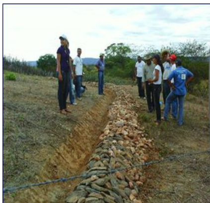
CORDÃO DE PEDRA
