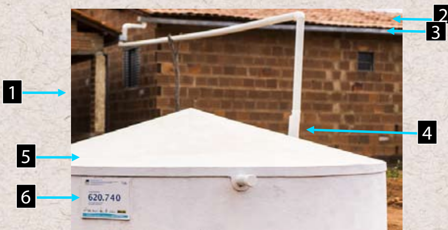
Figura 1: Componentes do sistema de aproveitamento de água de chuva construído pelo Programa Um Milhão de Cisternas.
