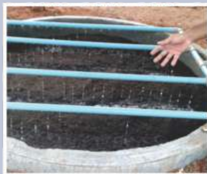
Foto 23 - Filtro biológico, detalhe do chuveiro que distribui água cinza no FB.
