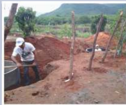
Foto 09 - Escavação para montagem dos anéis de concreto para o filtro biológico e tanque de reuso
