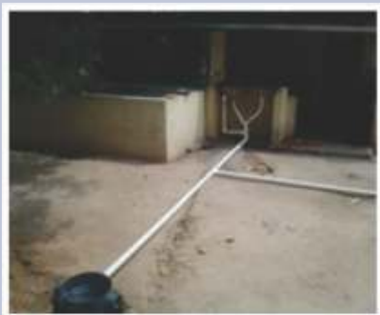
Foto 08 - Detalhe da caixa de gordura e da convergência hidráulica onde passam as água cinzas
