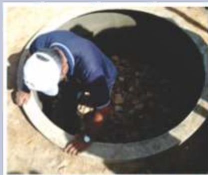
Foto 11 - Filtro biológico sendo preenchido com camadas de pedras
