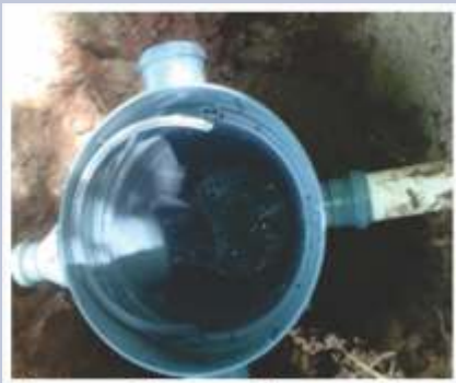
Foto 01 - Caixa de Gordura com detalhe do cesto que facilita a limpeza da mesma
