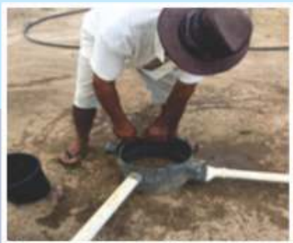
Foto 14 - Beneficiário realizando a limpeza da caixa de gordura
