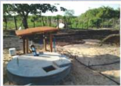
Foto 03 - Tanque de Reuso com eletrobomba, local de armazenamento da água cinza tratada
