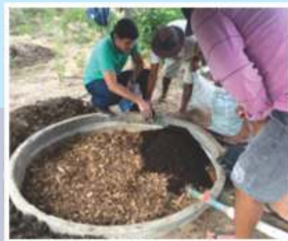
Foto 15 - Manutenção do filtro biológico, troca das camadas de húmus e raspa de madeira
